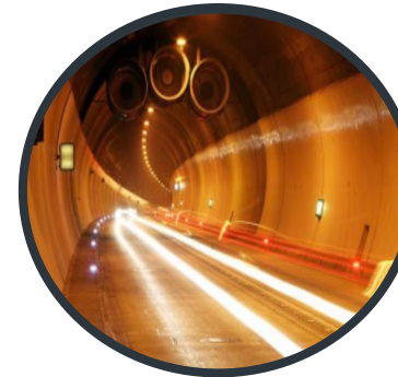
Systèmes de ventilation avec extraction de fumée en zones critiques
